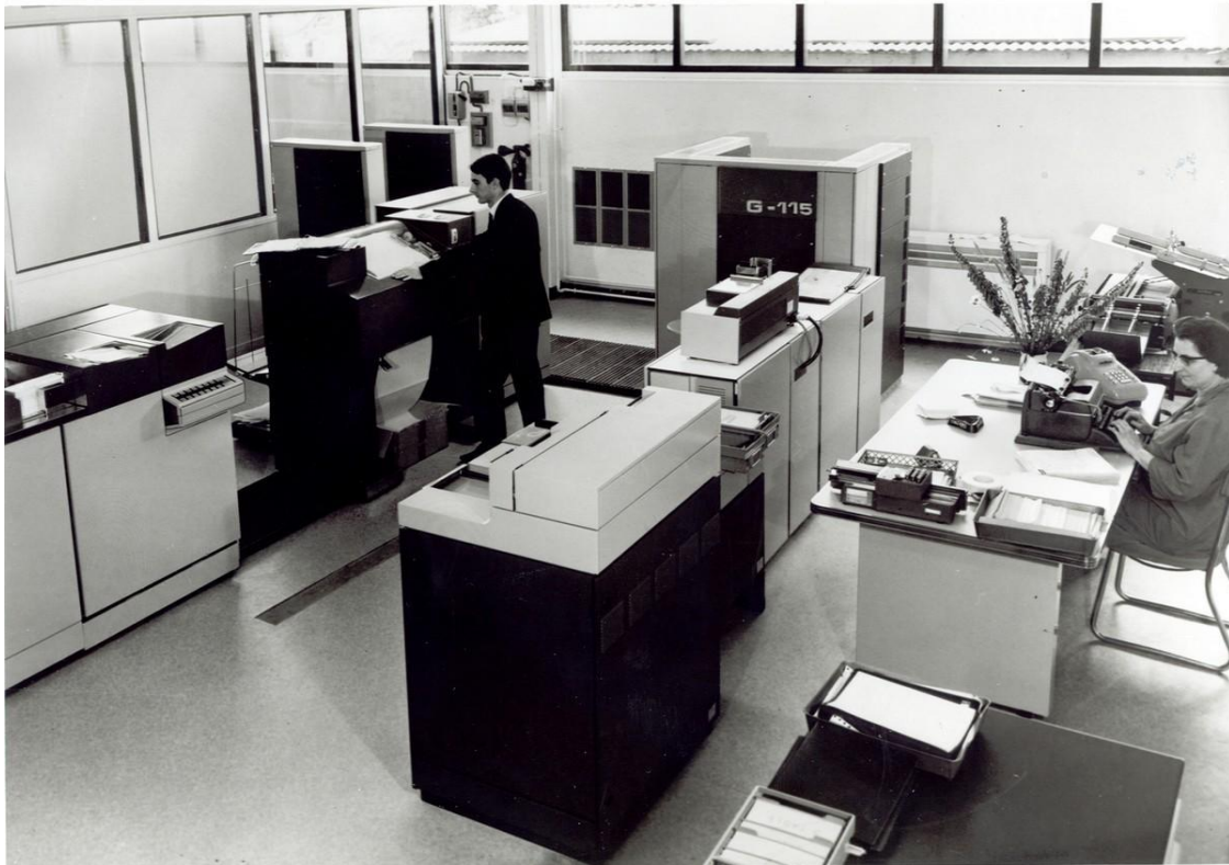
Fig. 1 - Un système Gamma 115 au Centre de Calcul de Bull General Electric à Paris, avec imprimante, unité centrale, lecteur de cartes et de documents, perforateur de cartes, 1965. Photographie de Jean-Claude Massa, avec l’aimable autorisation de la Fédération des équipes Bull – Patrimoine.
