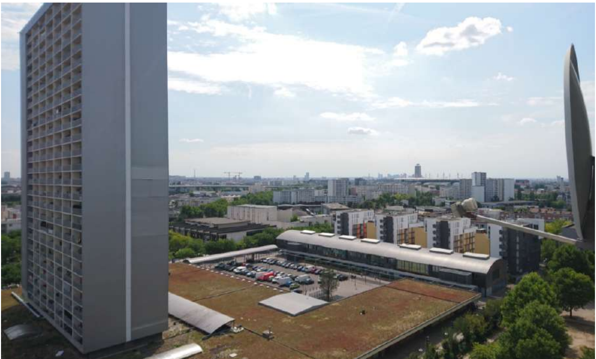
Figure 5.3. La Tour Leclerc à la Cité des 4000 Sud à La Courneuve (© Jacqueline Maurer, 18.7.2017)
